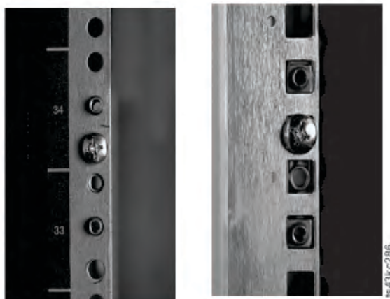
Figure 38. Emplacements de connecteur corrects
