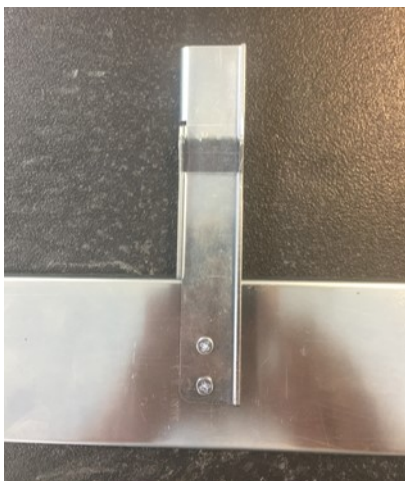
Figura 30. Fixação de CMA instalada no trilho deslizante externo
