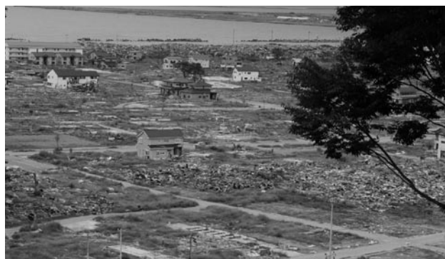
図1. 津波によりほとんどの建物が押し流された港湾部近辺
