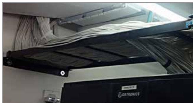
Figure 4 : Armoire de commutation d'une petite société. Le côté gauche de l'image montre le rack de commutation principal avec d'énormes groupes de câbles entremêlés. Le côté droit de l'image montre l'énorme ensemble de câbles allant de la baie vers la distribution horizontale du niveau et des étages (distribution vers les boîtiers de prises informatiques).
