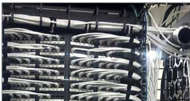
Figure 4 : Armoire de commutation d'une petite société. Le côté gauche de l'image montre le rack de commutation principal avec d'énormes groupes de câbles entremêlés. Le côté droit de l'image montre l'énorme ensemble de câbles allant de la baie vers la distribution horizontale du niveau et des étages (distribution vers les boîtiers de prises informatiques).
