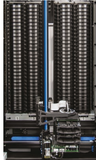
All'interno IBM TS4500 Tape Library
