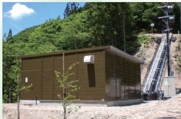
図6. 福島県下郷町小水力発電所
