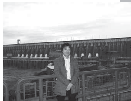
ブラジルでは、イグアスの滝にある世界最大級の水力発電所にも訪れた。
